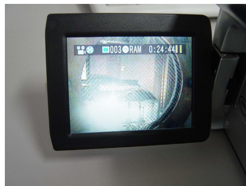
図 5: オイルタンク内、パルストランス付近での大きな放電。インターロックにより運転を停止した。トランス等には全くダメージはないことを確認し、運転を再開した。
