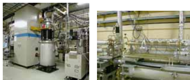
図1：KEKBライナック4-4ユニットの地上部に設置されたCバンドRF源（左図）とトンネル内に設置された1m長加速管（右図）
