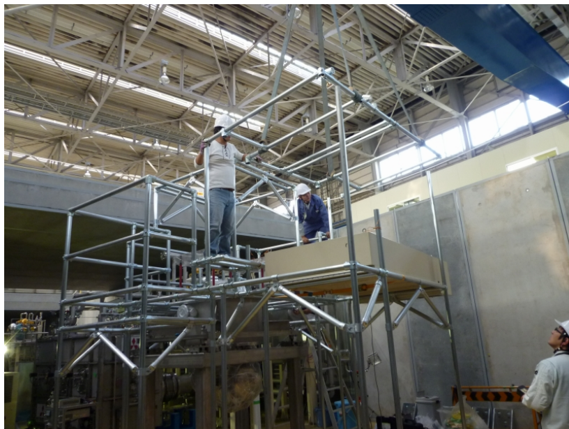
シールド内で電子銃の足場組み立て(2012/10/22)
