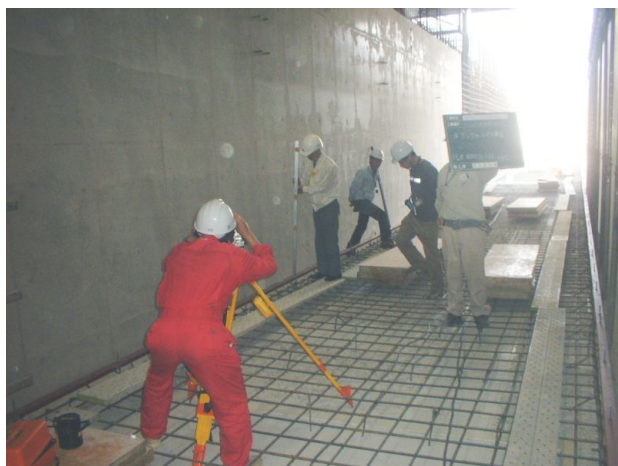
写真1. 両サイドのアングルレベル確認時の様子
