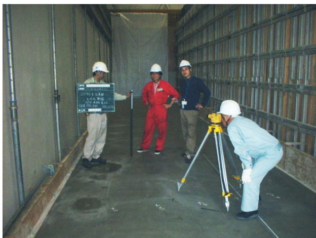
写真5. 施工後床レベル確認時の様子
