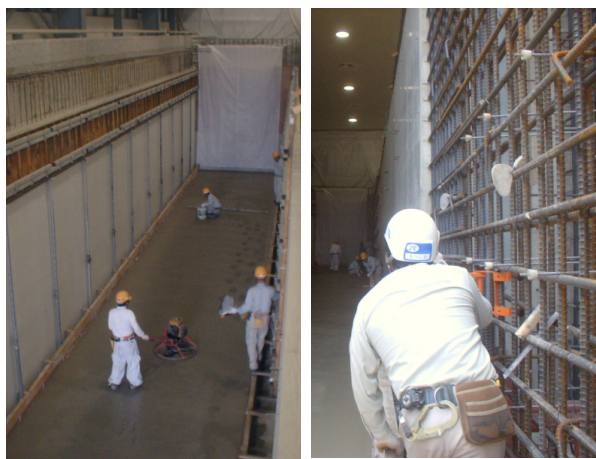
写真3,4. コンクリート天端押さえ時の風景
