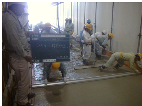
写真2. 定規を使った土間ならしの様子
