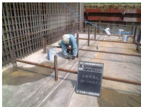
写真6 水平施工打継ぎ面の止水対策
