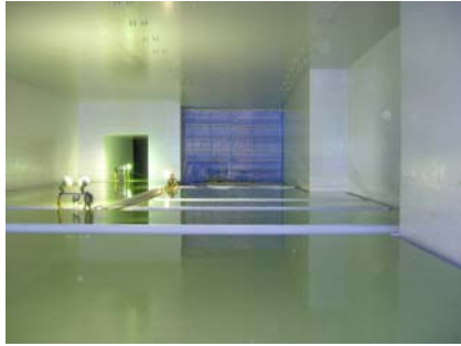
写真4 塗装完了 (7~9ブロック)
