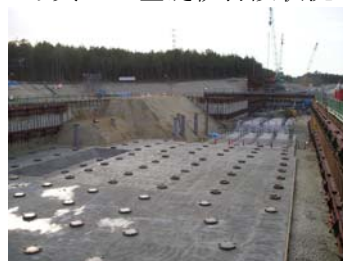
写真2 均しコンクリート打設完了
