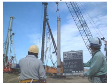
写真1 基礎杭打設状況
