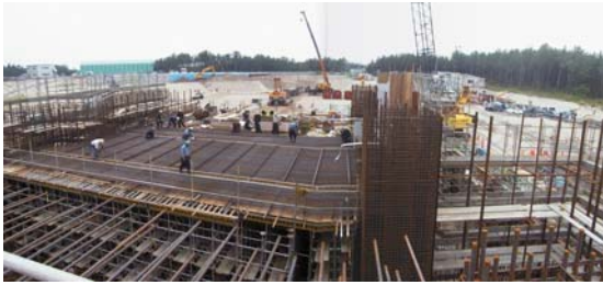
写真3 頂版鉄筋組立状況 (9ブロック)
