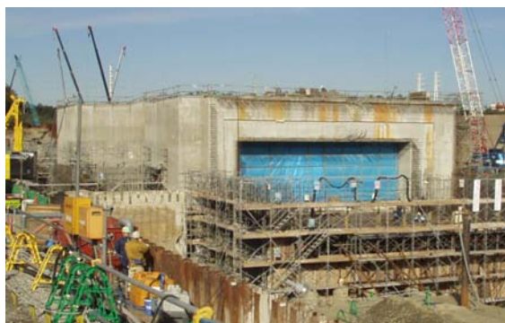
写真5 対象構造物の施工状況
