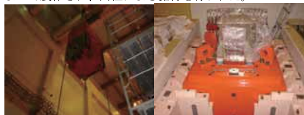
図4 一次ライン電磁石 (QM1) 吊り上げ・据付
