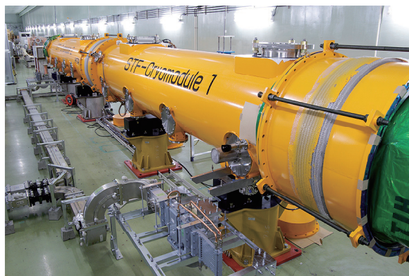
図1、トンネル内に設置されたクライオモジュール。この内部には温度センサー等200点以上が仕込まれている。左下にはカップラー接続待ちの導波管。
