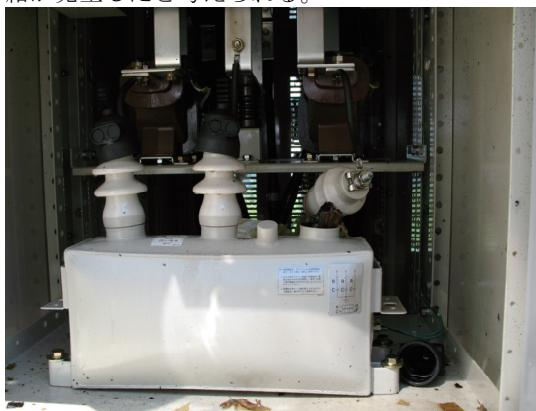
図3 損傷したサージアブソーバー
