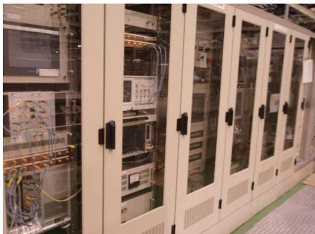
図. 2 制御ラックの外観。手前から順に、LLRF、KlyPS、TANK、Tunerの制御PLCが並ぶ
