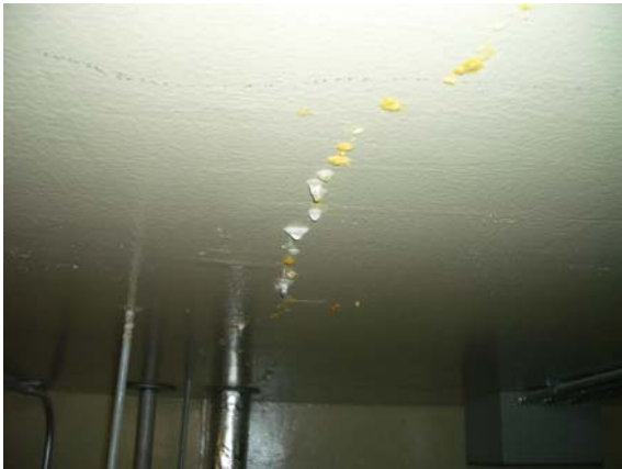
図4 漏水箇所の例 (RCSサブトンネル天井)
