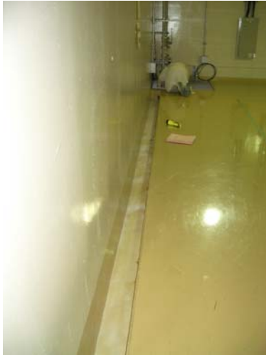
図3 漏水例 (LINAC上流部) : ホースで導いて ピットに流し込んでいる
