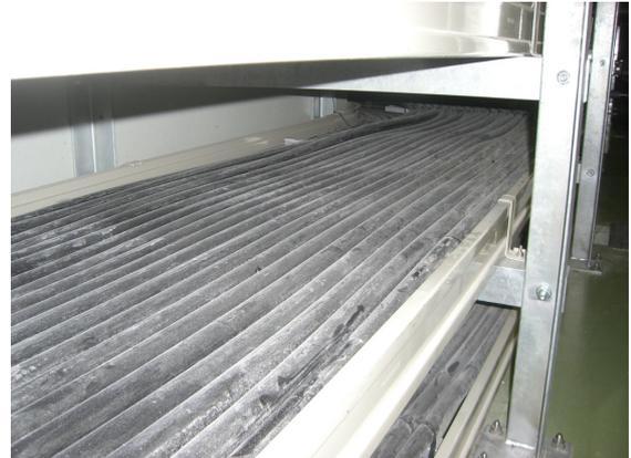
図4：離隔のない325sqケーブル配置(3-50BT部)
