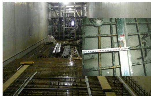
図 2. トンネル内上床（40cm 分）の鉄筋。
