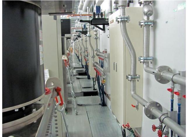
これらの各分電盤の必要回路数はほぼ同じであった。多少の回路数、ブレーカー容量の違いはあったが、最も回路数の多い分電盤と同一サイズで、すべての箱体を製作した。各盤ごとに必要なブレーカは実装し、空いた部分は予備スペースとした。各盤への分岐幹線サイズも同サイズとすることにより、予定されていた個別負荷に変更があった場合も、盤内ブレーカの交換、追加のみでほぼ対応可能となる。箱体をすべて同一サイズとすることによって、冷却水配管など他設備との取り合いも統一され、高密度に機器類が設置される空間を有効に活用できる。
