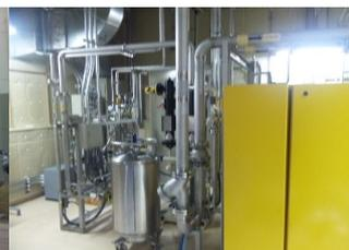
図 12: 第 2 ヘリウム圧縮バッファータンク 2 基 (右) 機棟: 圧縮機、オイルセパレーター
