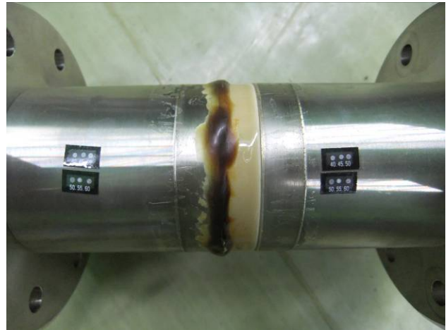
図4：シール剤が劣化した絶縁配管 前後に温度測定シールで温度を確認したが、マークの変化はなかった
