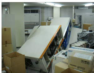
制御ラック転倒（運転に使用しているラックは床に固定していたが、たまたま使用していないラックをそのまま放置していたところ地震で転倒し、巻き添えて隣の制御ラックまで転倒してしまった）
