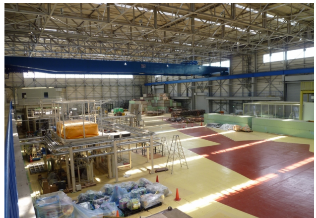
図5：2011 年 5 月現在の ERL 開発棟内。写真左手に冷凍機システムが設置されており、右手のスペースに cERL が建設される。赤色ペイントが施された床は、弱く放射化された部分を示す。
