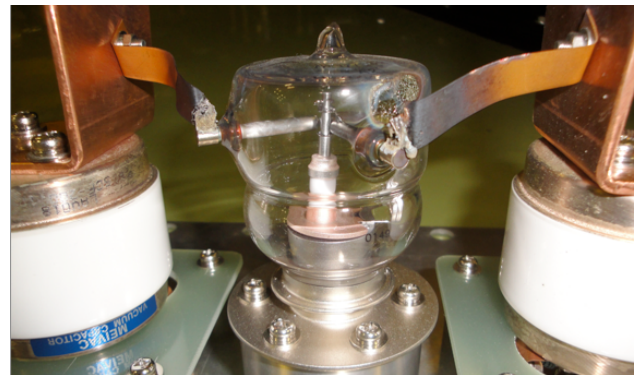
図 2 : 損傷した真空リレーと銅導体(W9mm, t0.2mm)
