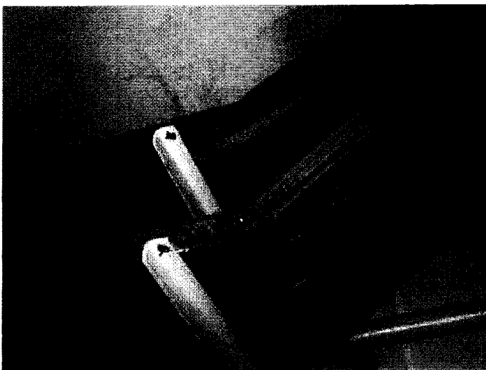
6-A 光ケーブル配線 施工後
