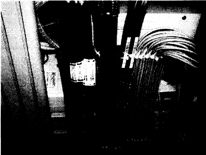
主制御室 ケーブル行き先札取付 施工後
