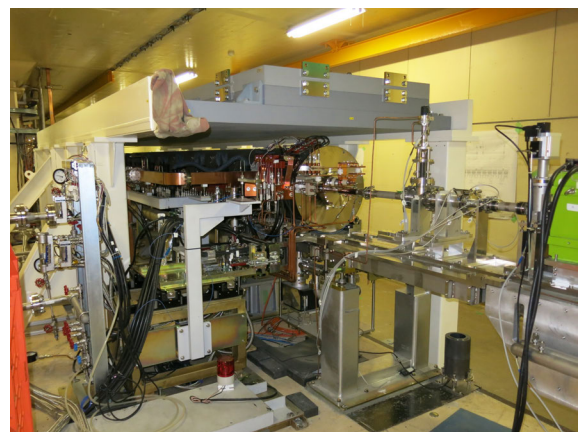
Figure 7: 陽電子生成部の上方に構築された遮蔽体構造。
