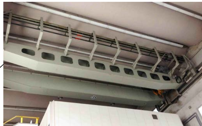
AVF本体用クレーン
