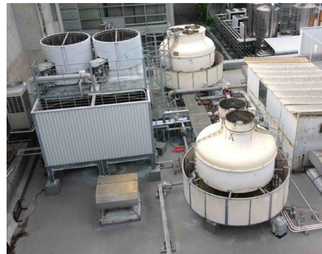
AVF冷却塔 3基
