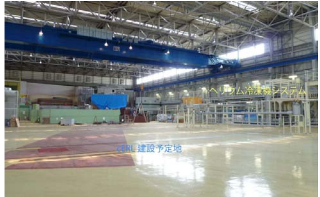
図 4: 改修後の東カウンターホール内部
