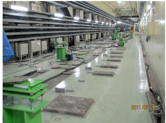
図 6 : 電磁石撤去をほぼ終えた筑波直線部。
