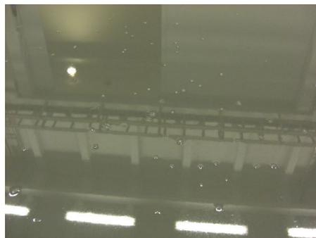
図4：AT150 1回目の打設後にできた表面の泡。直径約5mm程度
