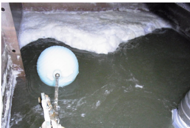
図3：微生物が異常に増殖した際の冷凍機循環冷水リザーバータンク内の様子。大量の泡が発生し冷水が緑色に変化。
