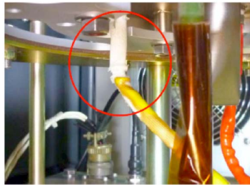
図7：サイラトロンヒータ線の被覆劣化
