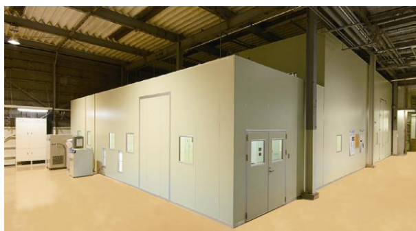
図 2 クリーンルームの外観図 正面 19 m、奥行き 14 m、高さ 5 m (一部 3.5 m)
