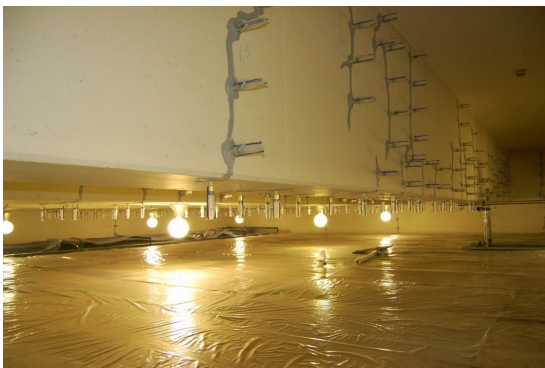
図 2：第 2 測定室の天井亀裂の補修状況
