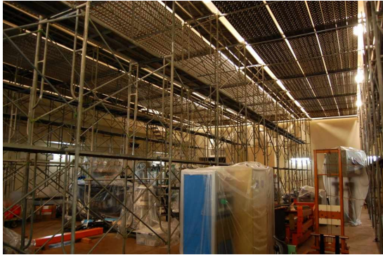
図 1：第 2 測定室内の天井及び壁の補修状況
