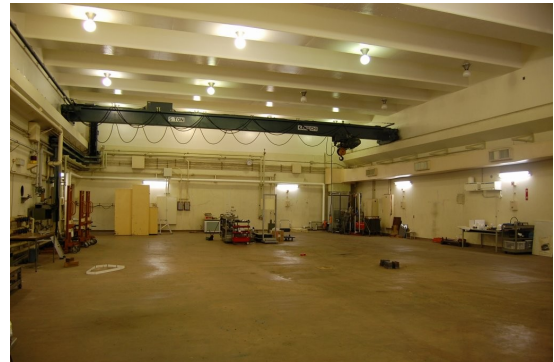
図 3：既存の全ビームラインが撤去された第 2 測定室の現況
