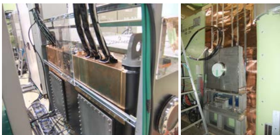
図 4：キッカー電源および周辺に施された放射ノイズ遮蔽(RF Shield)。キッカー電源の電力導入端子(feed through)部分の遮蔽(左)およびキッカー電磁石下流ビームラインと実験エリアとの境界部分の遮蔽(右)
