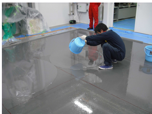
図 2：大面積床面への樹脂材料混合液の散布の様子。床に書かれた区画に従って流す。
