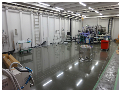
図 3：エポキシ樹脂床を打設した相互利用施設実験ハッチ内の様子。
